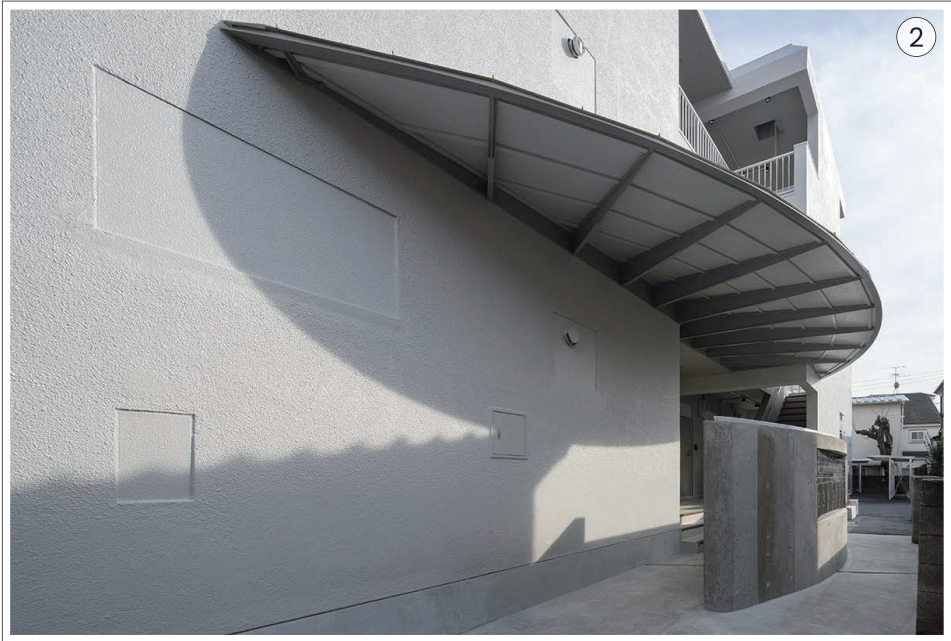
エントランスを新設し、オートロックや照明によりセキュリティや安心感をもたらした。
