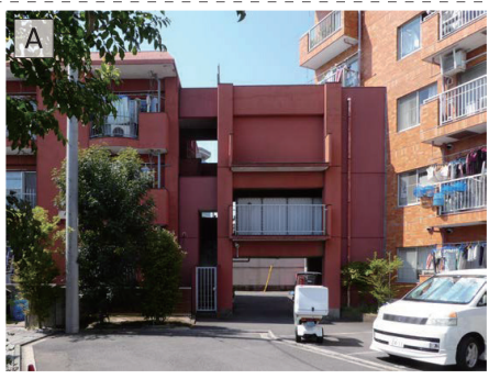
既存の住棟をバルコニー側から見る。
