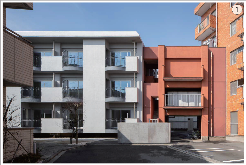
改修した住棟は4種類の無彩色でカラーリングし、既存の立体感を強調。
