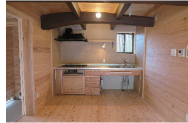
⑦既存軸組に挿入した造作キッチン
