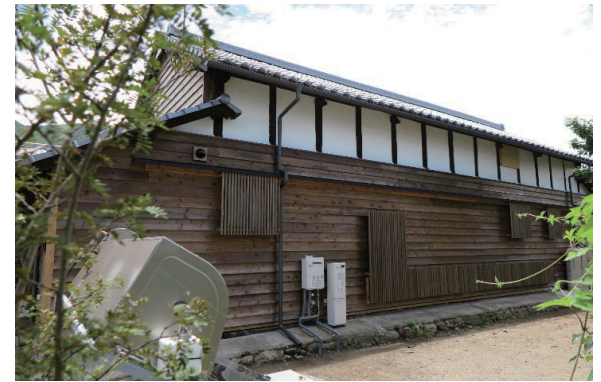
⑩再生後外観 西面には通風のための地窓が連続する
