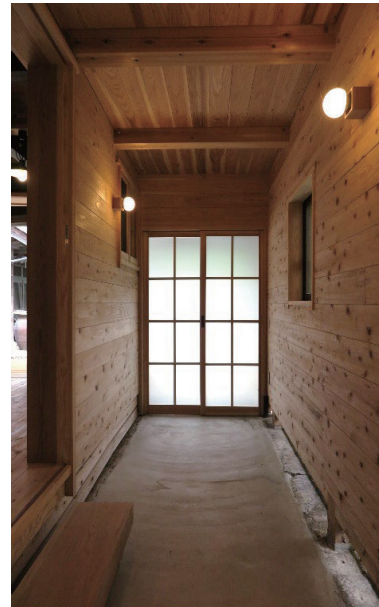
⑥半屋外納戸は温熱の緩衝空間でもある
