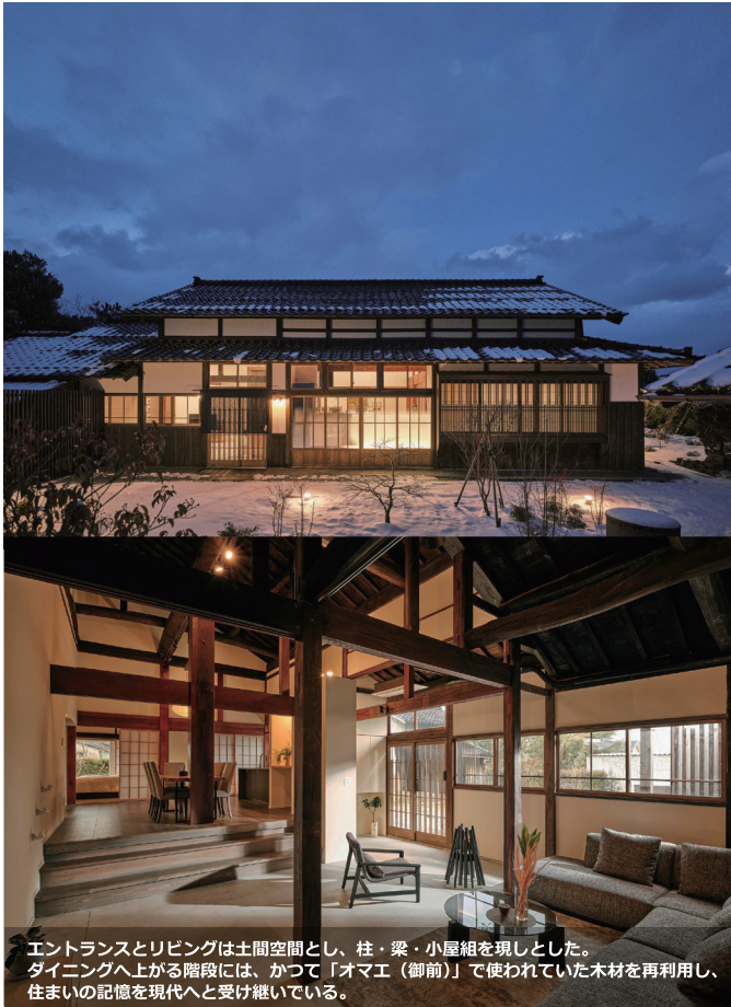
劣化した柱脚部や梁を適切に補修・補強し、壊した漆喰壁を練り直し再利用するなど、日本の大工工事の伝統手法を採用すると同時に、床暖房の導入・断熱改修・建具更新により、冬季にも快適な滞在環境を整えた。
