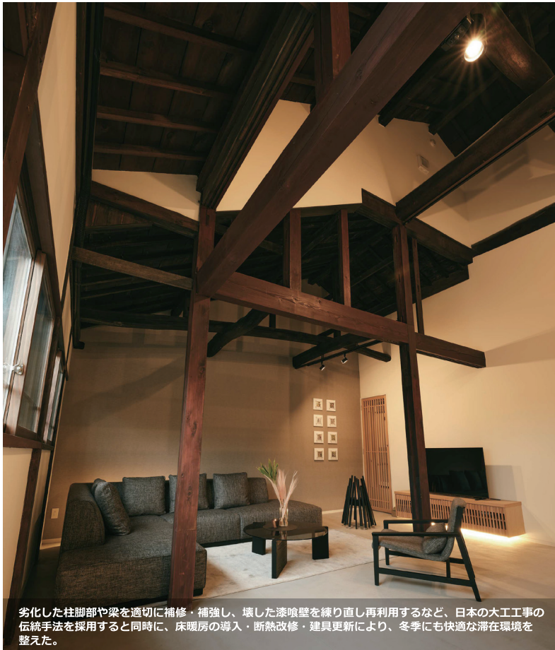
エントランスとリビングは土間空間とし、柱・梁・小屋組を現しとした。ダイニングへ上がる階段には、かつて「オマエ（御前）」で使われていた木材を再利用し、住まいの記憶を現代へと受け継いでいる。
