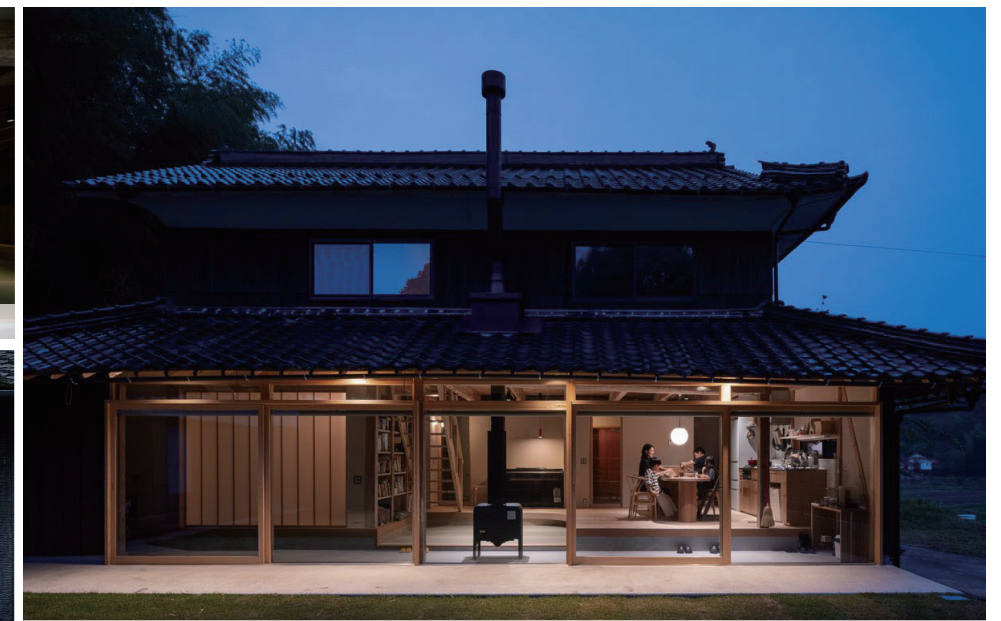
8. 南東側外観 連続した開口と土間によって庭と連続した空間
