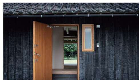
6. 玄関 焼杉の深い質感と木製建具の温かみ
