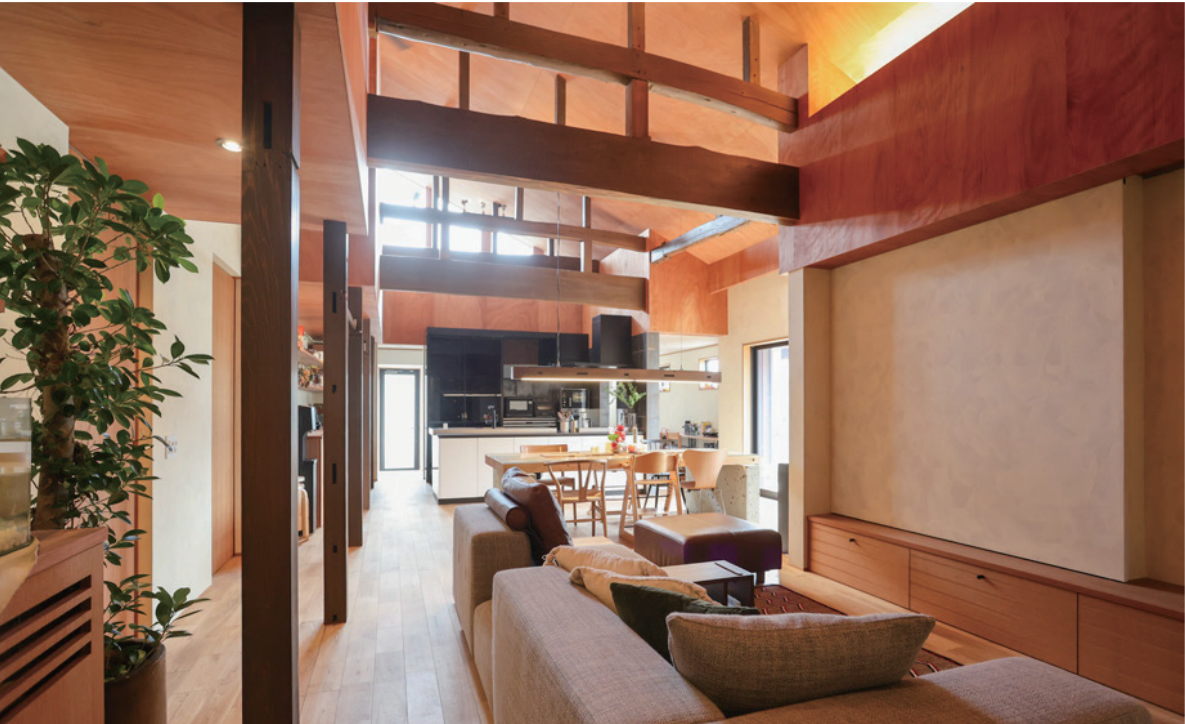
① 既存柱を活かし、太鼓梁（五泉杉）などの構造補強で開放的な高天井を実現。セルフメンテナンスを見据え、木部の研磨・塗装作業などは施主が担当した。難聴児は音だけでなく、口の動きや表情、身振りなどからも多くの情報を得るため、家族がお互いの様子を感じ取りやすいことを大切にした。
