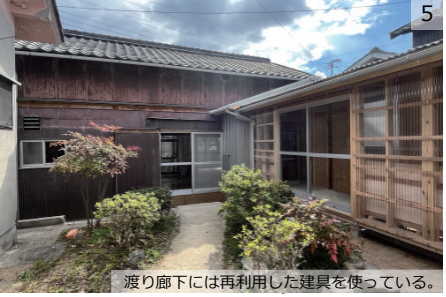
中庭に増築された渡り廊下を見る。改修前の建物にみられた増築趣味を参照し、外壁や屋根を波板で仕上げた。
