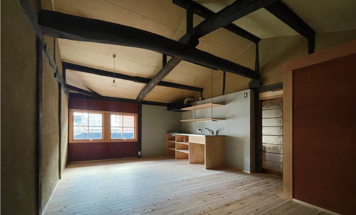
③住戸A居間。告示仕様の木製防火窓を制作し、修景と防火性能を両立。左手は補修した既存土壁。
