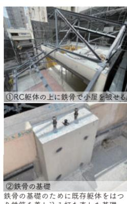
①RC躯体の上に鉄骨で小屋を被せる。
