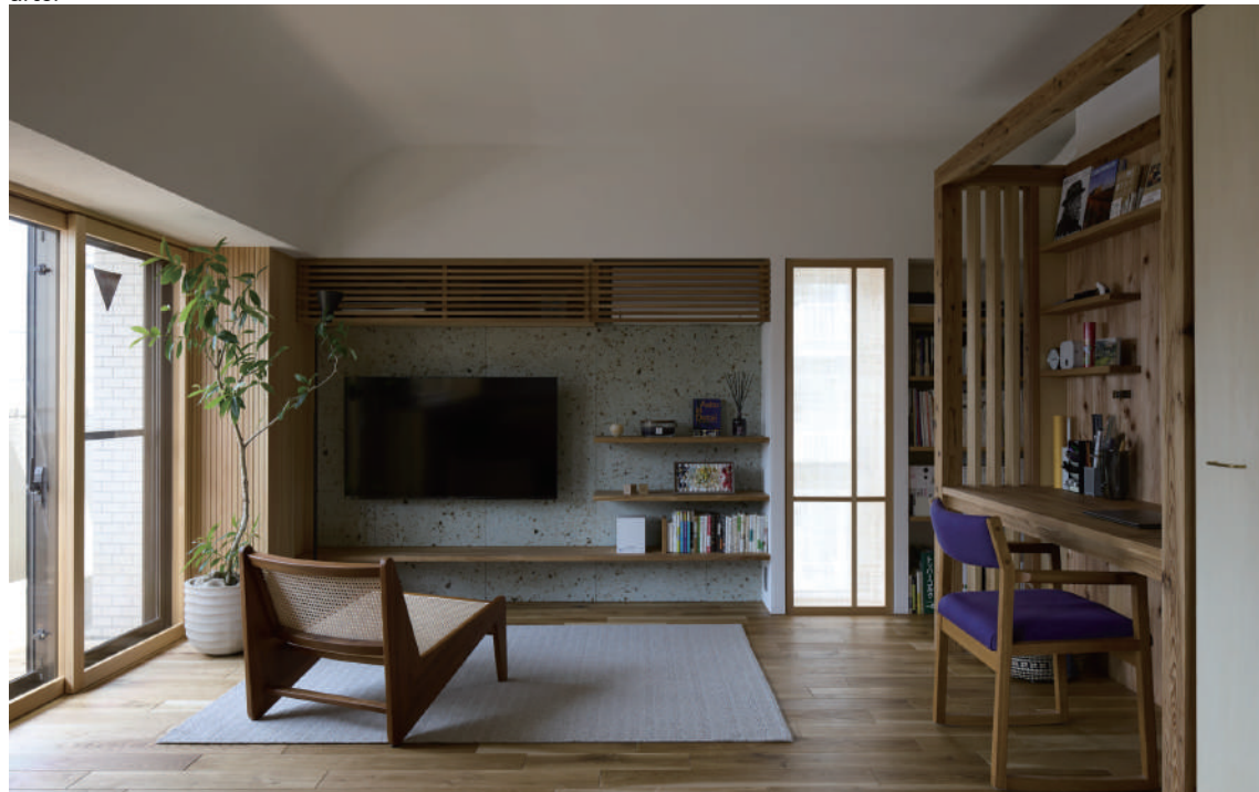
①マンション特有の大きな柱梁の存在感を消すことで、羽目板や大谷石の素材感が引き立ち木造住宅のような空間とした。
