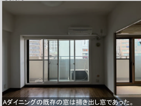
Aダイニングの既存の窓は掃き出し窓であった。
