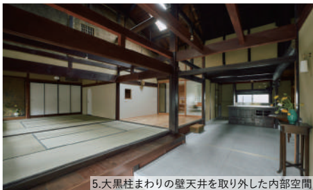
5.大黒柱まわりの壁天井を取り外した内部空間
