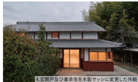
4.玄関戸及び書斎窓を木製サッシに変更した外観
