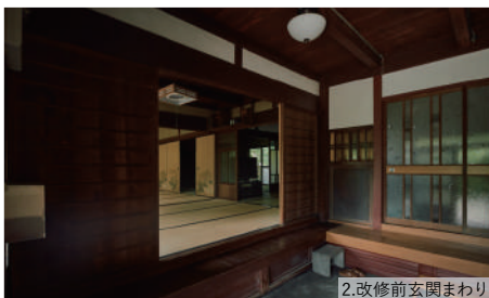
2.改修前玄関まわり
