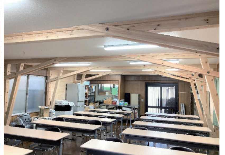
方杖計画詳細図(補強材は鉄骨梁へ貫通取付はせず木材での挟み込みとしている)
