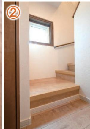
② 鉄骨梁と階段の高さを考慮し、2段目が梁の直下になるよう調整。段数はそのままに、踏面を22mm延長出来た。
