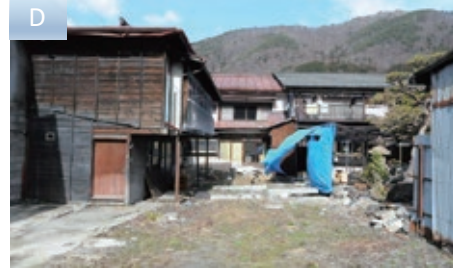
裏の崩れた塗蔵等を4棟壊されてきた庭(再生前)
