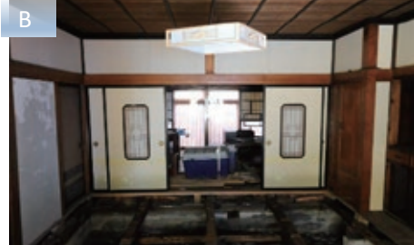
床下浸水床で落ちた漆塗の和室(再生前)
