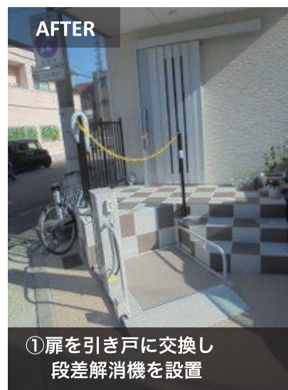
②ポーチを嵩上げし上がり框の 段差を解消
