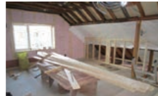
外壁面：ウレタン断熱60mm 熱伝導率：0.021W/(m・k)
