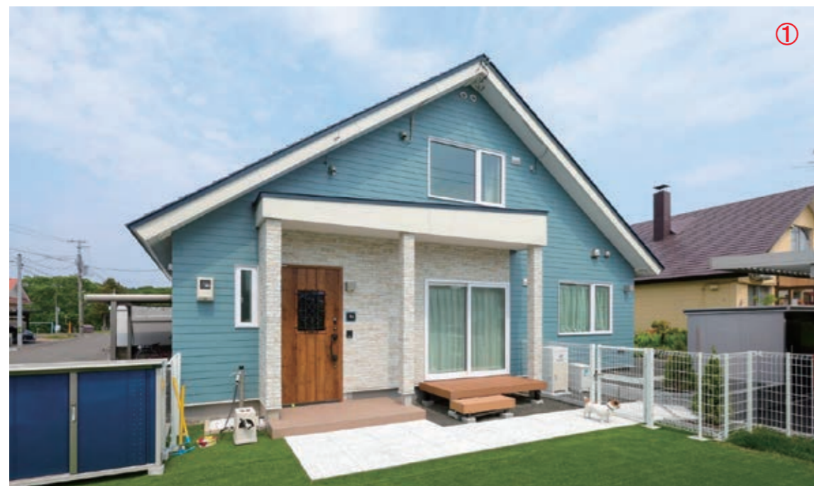
外壁面：ウレタン断熱60mm 熱伝導率：0.021W/(m・k)
