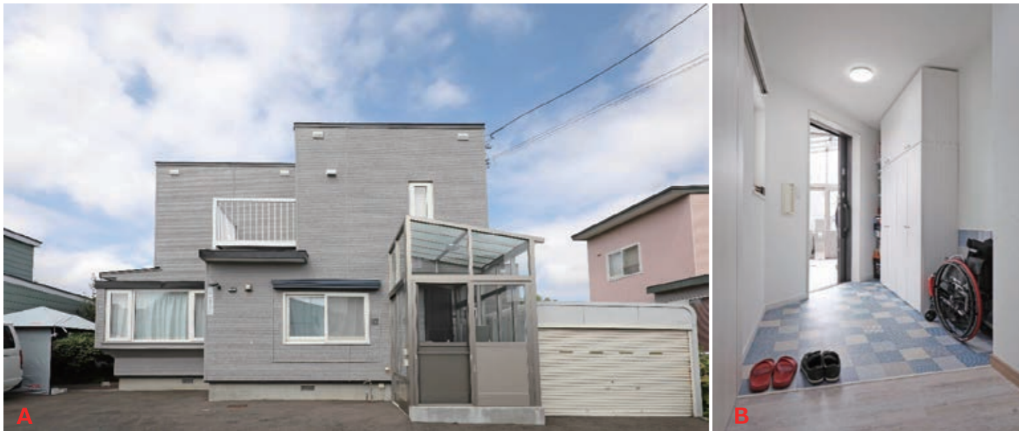
A 積雪対策で設けた風除室は建蔽率・床面積増加の対象に 外壁後退距離緩和も考慮し、既存車庫を切り詰めて法令遵守した
