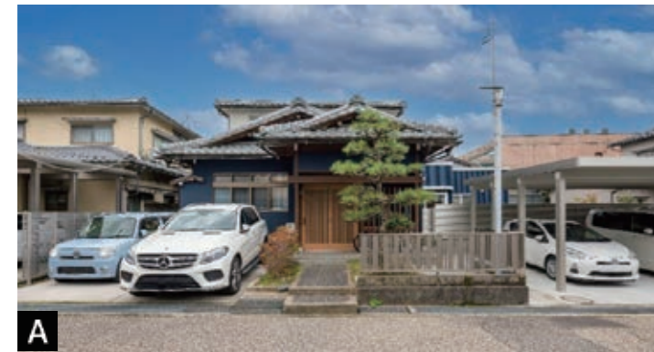
元々のカーポートをなくし、すっきりした建物正面。
