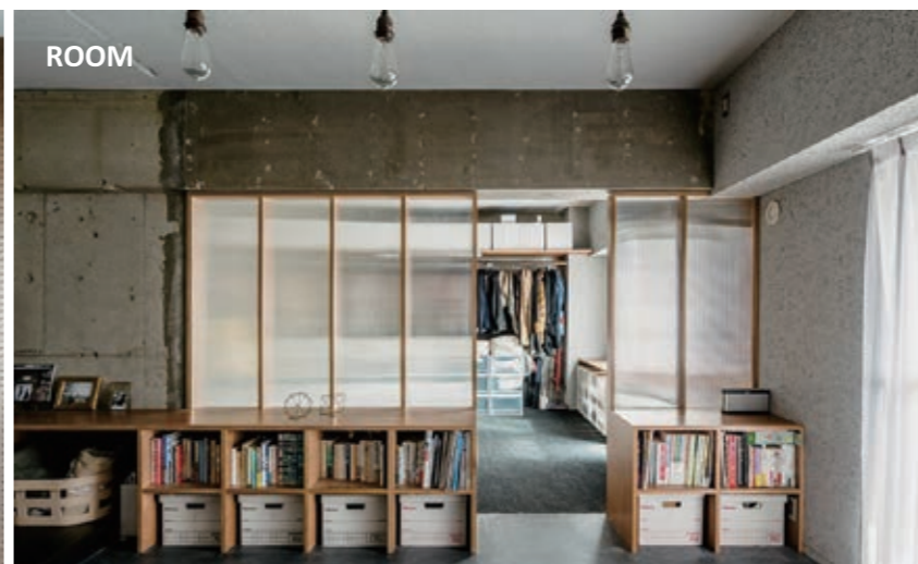
④ ペリメーターゾーンは断熱も兼ねて、木毛セメント板仕上げに。
