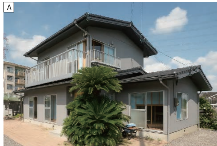
△外壁ラインからずらした断熱ラインにより、外部とのバッファゾーンが生まれている。
