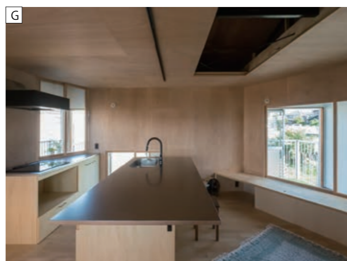
△2階世子帯リビング。天井に断熱開口を設け、既存の躯体を残し、吹抜けのような広がり確保している。
