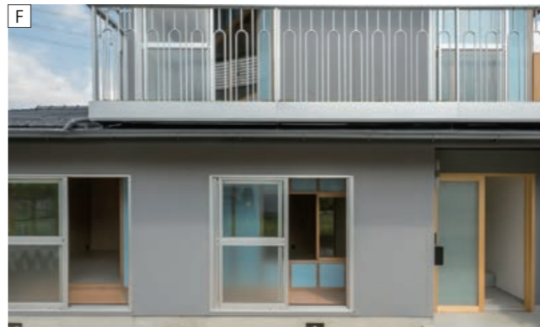
△既存の開口と新たに設けた断熱開口をずらすことで、プライバシーを確保している。
