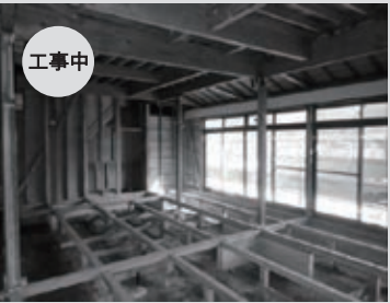
工事中 スケルトン状態まで解体。現況を調査し、既存筋交いと新設耐力壁+金物により耐震性を確保
