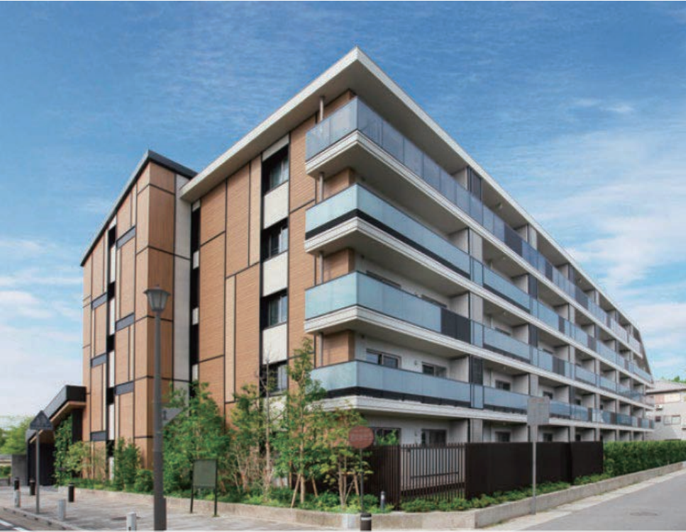
外断熱サイディングとガラス手摺に室外機目隠しパネルをランダム配置し外観を一新 ③
