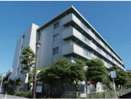
CON手摺のあるタイル張りの改修前外観 ① before
