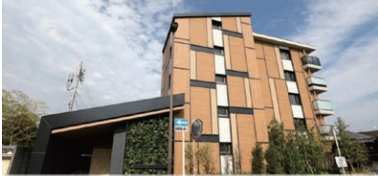
エントランスには壁面緑化を設置、外壁にも太陽光パネルを組み込み ④
