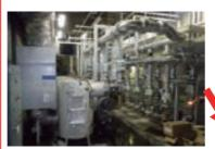
【サブステーション】=温水ボイラー設備 マンション内に温水を循環させて各戸 (360戸) に設置された熱交換器で給湯 を供給していた。※全戸改修後、解体。
