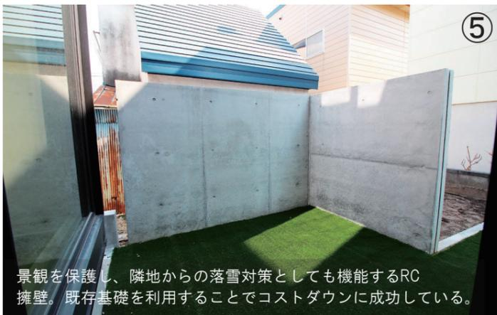
景観を保護し、隣地からの落雪対策としても機能するRC擁壁。既存基礎を利用することでコストダウンに成功している。
