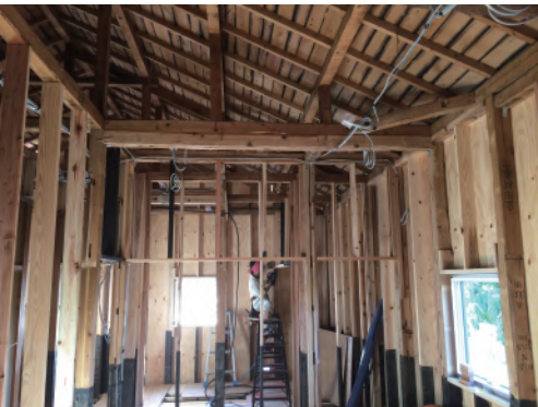
↑工事中：スケルトンにし耐力面材と断熱改修の様子。電気配線等も一新した。 ←模型：住まい手がイメージしやすいよう模型を必ず用意している。
