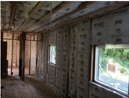
↑工事中：スケルトンにし耐力面材と断熱改修の様子。電気配線等も一新した。 ←模型：住まい手がイメージしやすいよう模型を必ず用意している。
