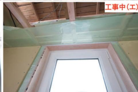
(ア)ユニットバスの基礎断熱部分。防蟻用パフォームガードを使用し防蟻処理をして気密シートを連結させて完璧に断熱気密を行う。(イ)既存壁には筋交いや間柱、補強材、下地材が複雑に絡み合うためグラスウールでは施工が大変になるので、セルローズファイバーも使用する。(ウ)エアコンダクト・給排気のダクト・コンセントなど、壁面に穴を開けるところには、事前にスリーブや気密材を使用して完全に防湿気密化をする。(エ)サッシまわりも、気密シートを連続させる。更に気密シートを合板でしっかり押さえる。天井の気密シートは事前に先張りシートとして張っていたもの。(オ)2階は外壁の張替だけだが、補強の為合板で外周部分を補強した。(カ)赤身の部分を選んで製材した杉板を横張りと縦張りで張り分けている。縦張りは、巾を60mm・90mm・150mmの3種類を使用して隙間を空けてラタン仕上げにしている。(キ)気密測定。C値0.24cm<sup>2</sup>/m<sup>2</sup>の結果が得られた。
