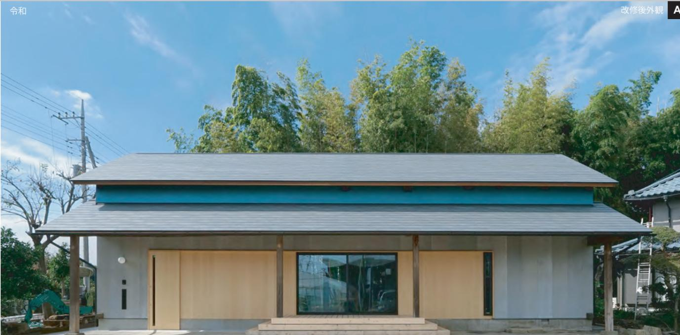
屋根や外壁には、セメント素材から湧き出す白華（エフロレッセンス）をあえて抑えずに1枚1枚異なる温かみのある窯業系の素材とすることで、既存の躯体との調和を図った。建物正面の下屋部分には米ヒバ（白木）を張り込み、古材とのコントラストを作ると共に、時の経過を楽しめるものとした。上部外壁は左官吹き付けにより、掛軸に残る、色鮮やかな青をアクセントとして復元した。
