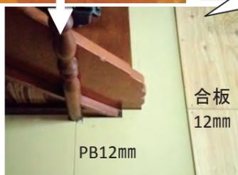
④3mm厚の車椅子用CFで仕上げ。カッターで切って施工できるので、複雑な凹凸にも対応でき、床の仕上げ工程は1日で完了。9mm合板2枚+フロア12mmでの嵩上げに比べ工期を半分に出た。
