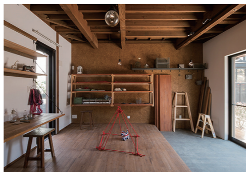
▲ハーベストパネルを利用した壁面
