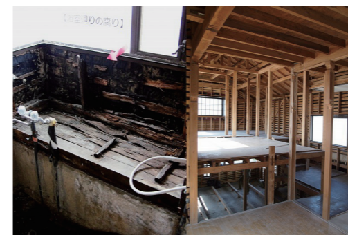
▲浴室まわりの腐りとフルスケルトン解体
