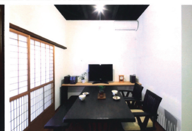
5 障子は古建具 大和天井や床は家主が塗装
