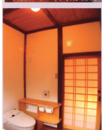
平成20年8月改修部分
