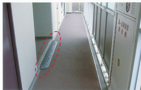
各階エレベーターホール
