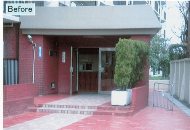
photo-1 : エントランスポーチ
