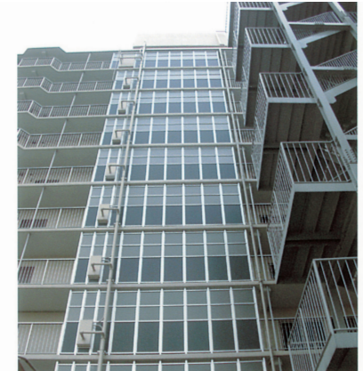
防風板を全階に設置、巾を広げてエレベーターホールへの雨の吹き込みを防止
