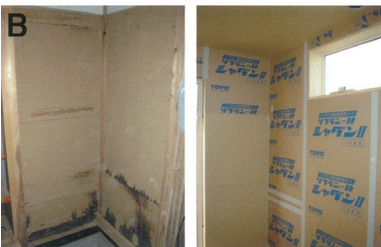
壁を表すと結露、カビが発生しておりこれを改修、板状断熱材で断熱した。
