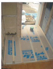
壁を表すと結露、カビが発生しておりこれを改修、板状断熱材で断熱した。
