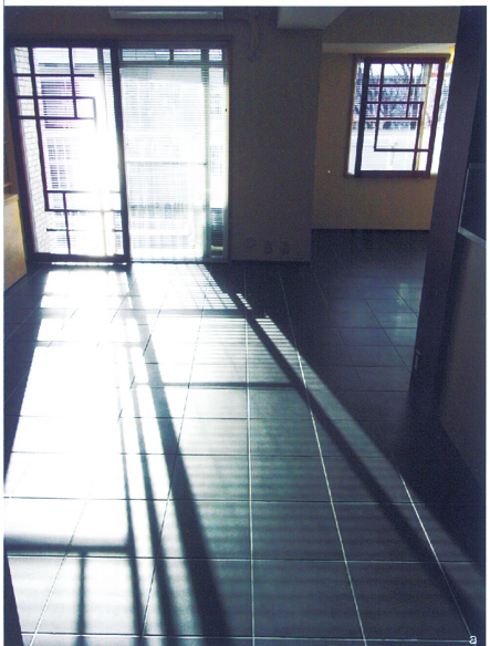
瓦のようなタイル貼りの床の上で暮らしが始まる。一部屋のみクローズドにした以外は、間仕切り、天井のダクト廻りを取り除き、すっきり広々と。建具はすべて引き戸で、ひとつながりの空間を実現。
