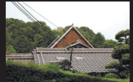
門屋の遠景 「蔵 Bar」に設けたガラス瓦の採光天窗が見える
