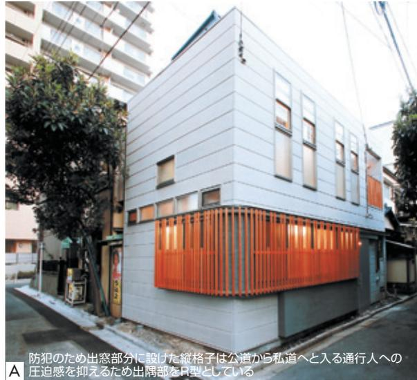
A 防犯のため出窓部分に設けた縦格子は公道から私道へと入る通行人への圧迫感を抑えるため出隅部をR型としている
