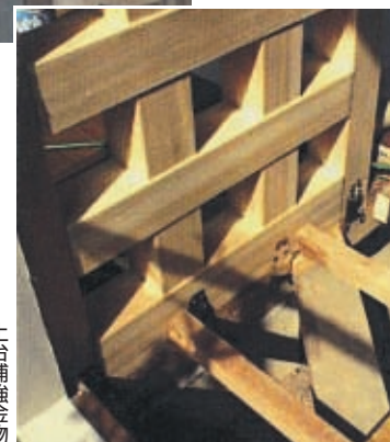
土台補強金物
