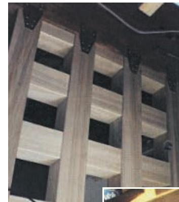
梁補強金物接合
