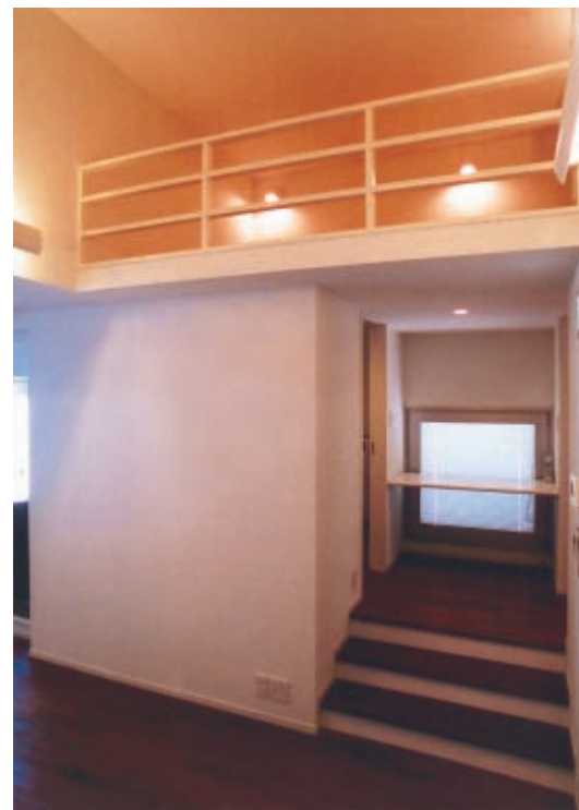
9 ロフトは水回り(洗面・シャワー室)のコア上に重ねている
