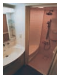
7 洗面・シャワー室(コンパクトにまとめた水回り)
