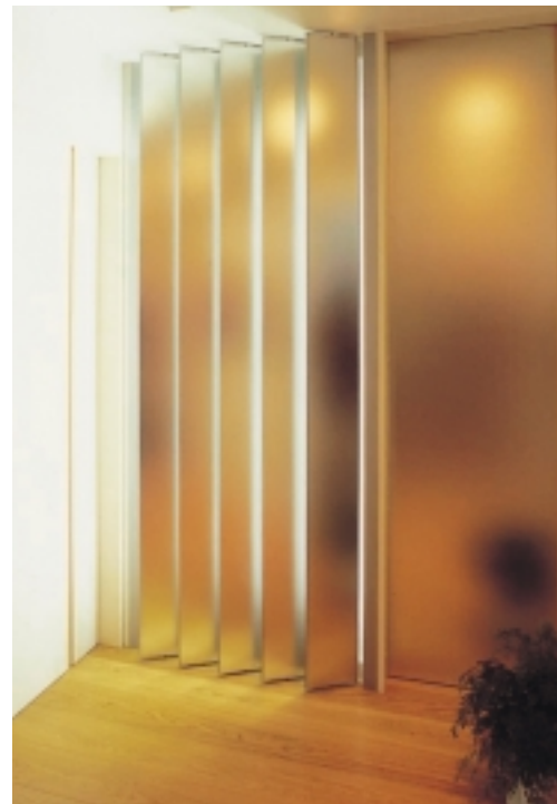
③ フロストミラーの後ろには、壁の中に縦長の蛍光灯が3本組み込まれている。
