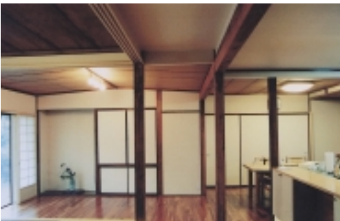
旧屋は多くの部屋に分かれていましたが、その柱梁を残して壁を撤去しオープンなワンスペースに。家の中心である床の間、収納は残置。
