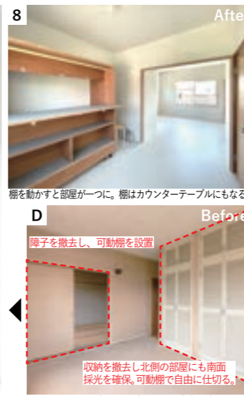
棚を動かすと部屋が一つに。棚はカウンターテーブルにもなる。障子を撤去し、可動棚を設置。収納を撤去し北側の部屋にも南面採光を確保。可動棚で自由に仕切る。固定された収納を可動式に変更する。
