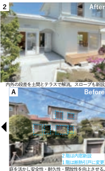
内外の段差を土間とテラスで解消。スロープも新設。庭を活かし安全性・耐久性・開放性を向上させる。
