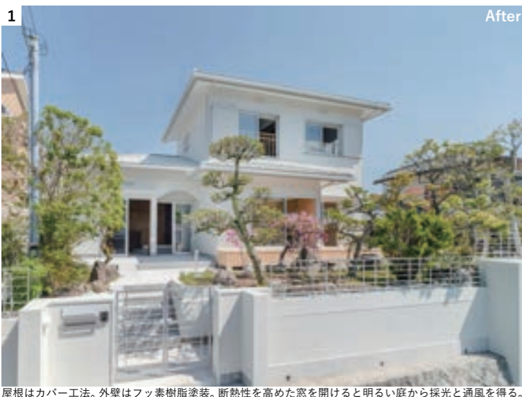
屋根はカバー工法。外壁はフッ素樹脂塗装。断熱性を高めた窓を開けると明るい庭から採光と通風を得る。
