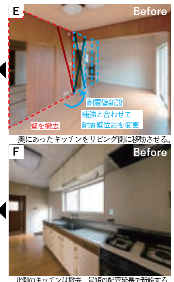
奥にあったキッチンをリビング側に移動させる。北側のキッチンは撤去。最短の配管延長で新設する。
