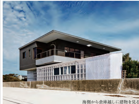
海側から倉庫越しに建物を見る
