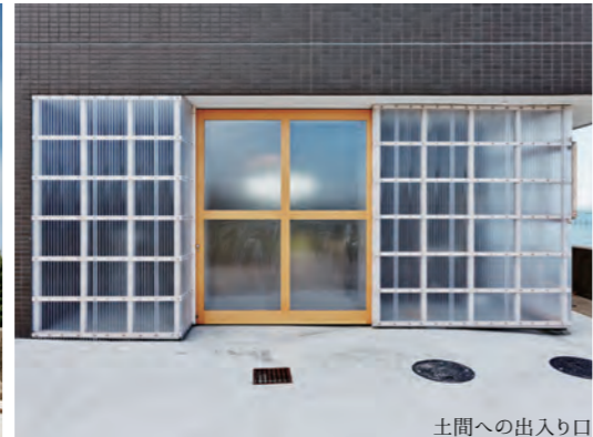
土間への出入口
