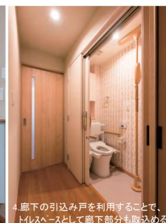
4. 廊下の引込み戸を利用することで、トイレスペースとして廊下部分も取込める
