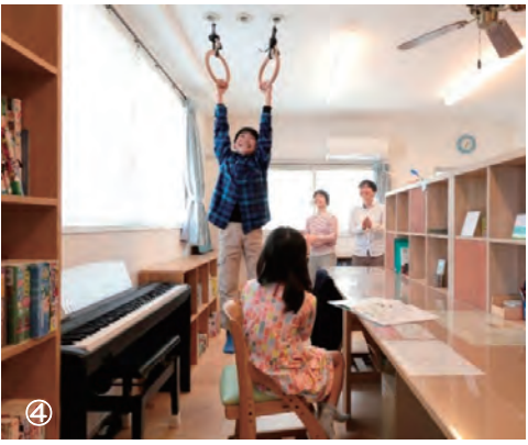
懸垂をするために取付けたつり輪。鉄骨梁に鎖を巻きつけ施工した。
