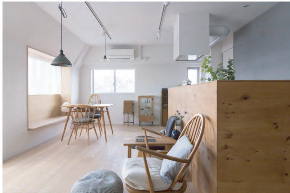
③ベンチと窓を一体で設え、開口部のプロポーションを整えている（ベンチ下は収納）
