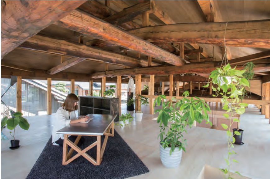
▲天井空間、梁の高さはFL+1.5mほどで、座ると視線が通り、立つと梁が視線を遮る。
