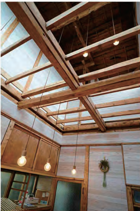
⑤南側の高窓を利用して明るくなったパン売り場。
