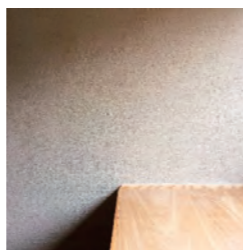
△壁の左官仕上げはシラス（火山灰）を使っている。
