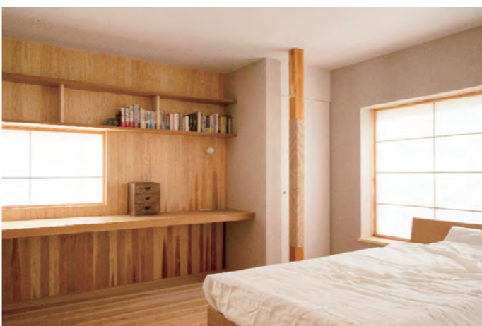
△寝室 左：既存木製窓に断熱サッシと紙障子を入れている。右：表しになる既存柱は紙紐巻き。
