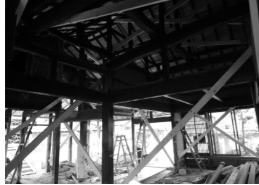
基礎、筋交いなどまともなものはない
