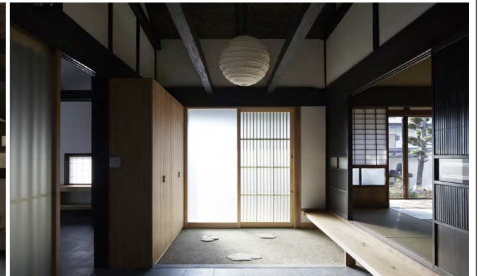
玄関：床は三和土とし、飛び石を散らし
