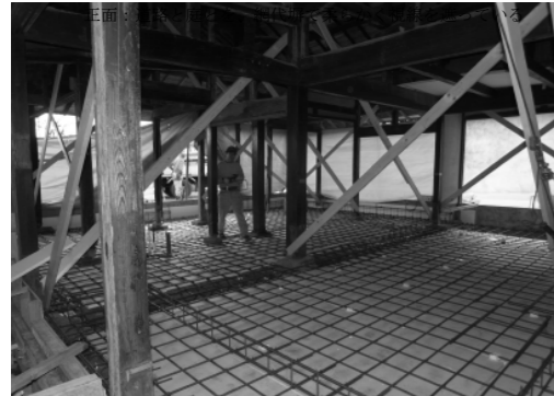
全面ベタ基礎とし、筋交いや金物で補強
