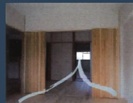
クローゼットを2つの室から使用できるようにして作った南北の風の道。引戸の扉は杉間伐材 35mm 製の板を加工。
