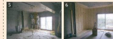
間仕切りを解体し、スケルトンリフォームを実施。外壁内側には35mm厚の硬質ウレタンフォームを吹き付け。
